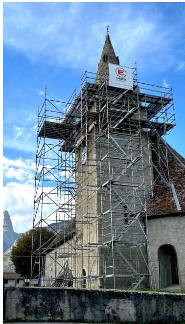
La première tranche de travaux a débuté le 21 octobre avec la mise en place d'un échafaudage permettant d'accéder facilement à tous les étages du clocher depuis l'extérieur. Les parois et colonnes des baies géminées un peu dégradées ont été reprises et rectifiées par les maçons. Ensuite il a été possible d'encastrer exactement les abat-sons en chêne. Ils constitueront désormais barrière contre l'eau qui pénétrait et altérait les poutres du beffroi.
