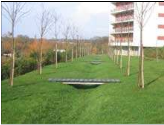
Figure 2 : Exemples de bassin d'agrément avec platelage bois de traversée
