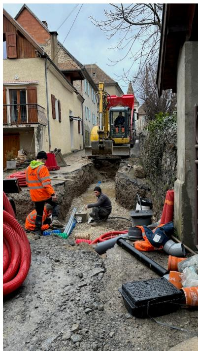
D'abord, le chantier a commencé depuis le bas du village par la réalisation d'une canalisation le long du ruisseau du Burlet. Cela a permis de raccorder à travers les jardins plusieurs maisons situées le long de la rue du Mont Aiguille.
